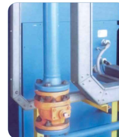
Eletrocalhas e conexões em fibra de vidro aplicadas na Plataforma de Carapeba. (Macaé. 1999)
