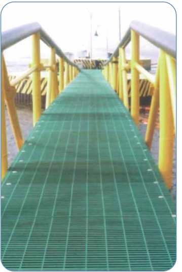
Aplicação de grade off-shore. Ilha D'água - RJ. 1999.
